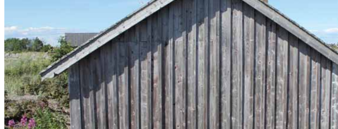
Den med rödmylla tidigare behandlade locklistpanelen har grånat Punamullattu rimalaudoitus on harmaantunut
