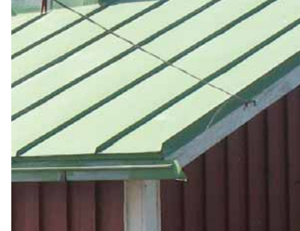
Gröna tak är ovanliga på fiskarbastur. Lägg märke till den elegant förverkligade hängränns utkastare.
