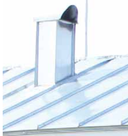
Nytt falsat plåttak Uusi saumattu peltikate
