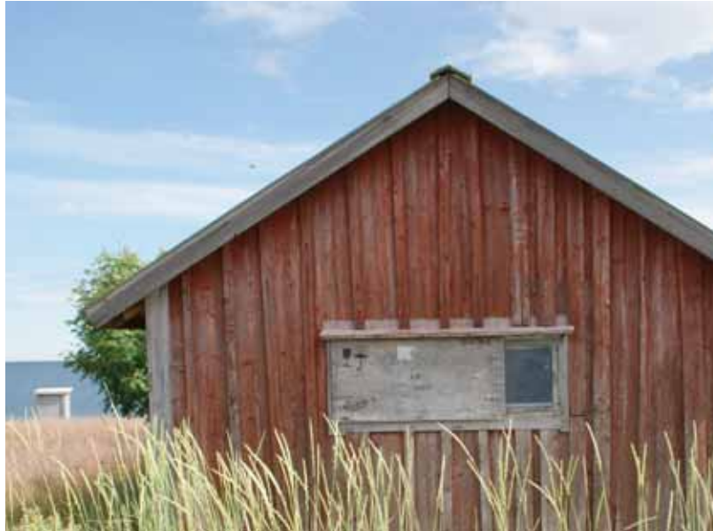
Den med rödmylla tidigare behandlade locklistpanelen har grånat Punamullattu rimalaudoitus on harmaantunut
