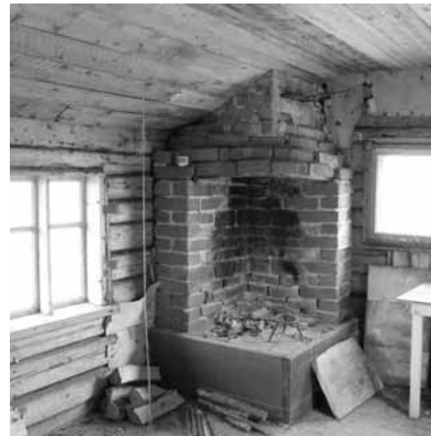
Exempel på fiskebastunas råspisar Esimerkkejä kämppien nurkkatakoista
