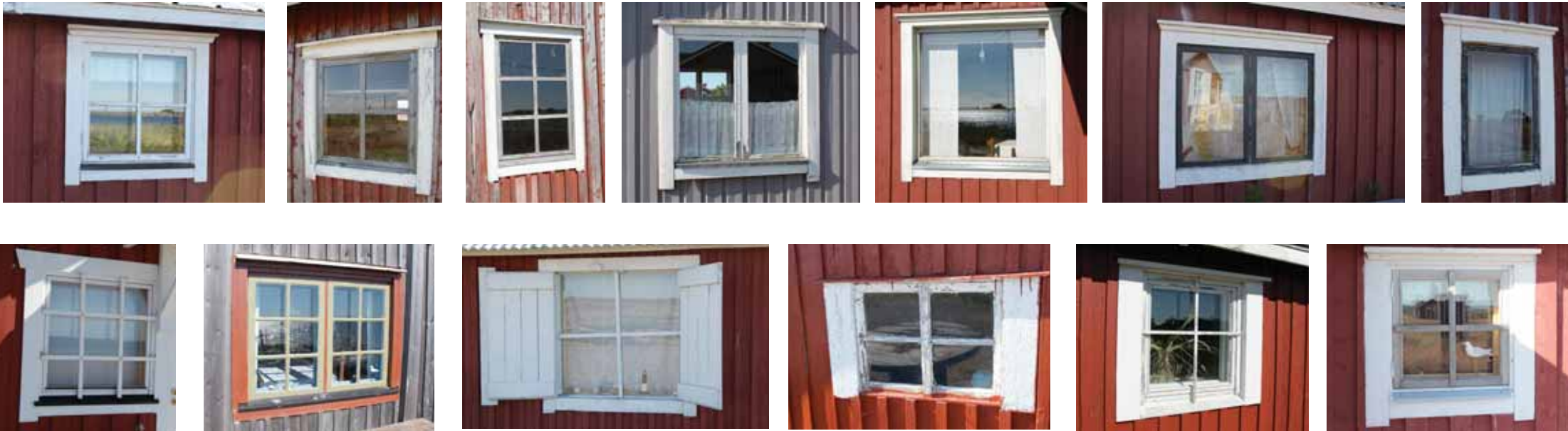
Fönster från inventeringsområdena Ikkunoita inventointialueilta
