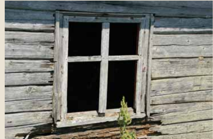
Södra fasadens fönster / Läntisen julkisivun ikkuna
